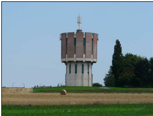
Figure 626 : Photographie du château d'eau chemin Millecamps
