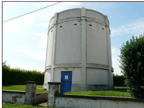
Figure 627 : Photographie du château d'eau chaussée de Mons
