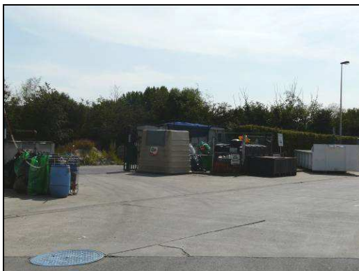
Figure 649 : Photographie du parc à containers, à Quenast
