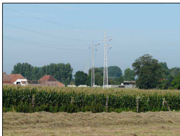
Figure 629 : Photographie de la ligne haute tension à Wisbecq
